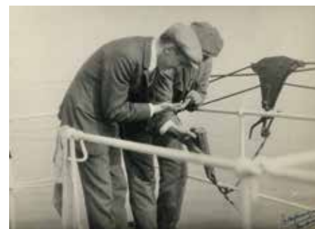
2. Bodemonderzoek met dieplood aan boord van het opnemingsvaartuig 'Eilerts de Haan'. Foto ca. 1925. Nationaal Archief, Den Haag: Dienst der Hydrografie, 2.12.20, inv. nr. 48.
