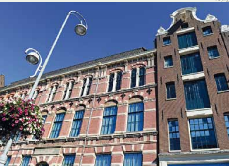
1. Het gebouwencomplex van de Bijzondere Collecties aan de Oude Turfmarkt in Amsterdam.
